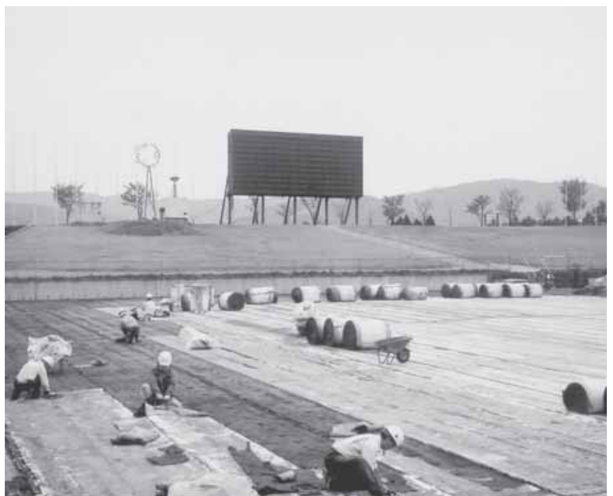
改修工事中のジャンプ競技場とスコアボード
