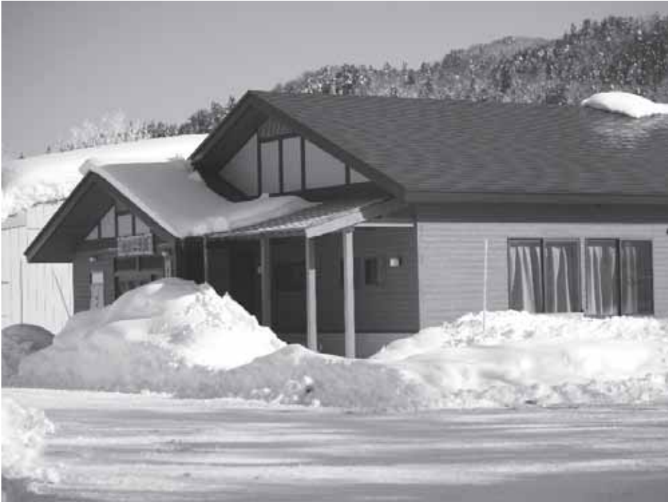
完成した飯田交流センター
