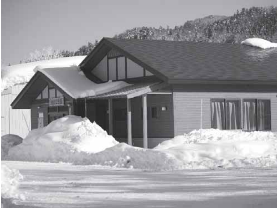
完成した飯田交流センター
