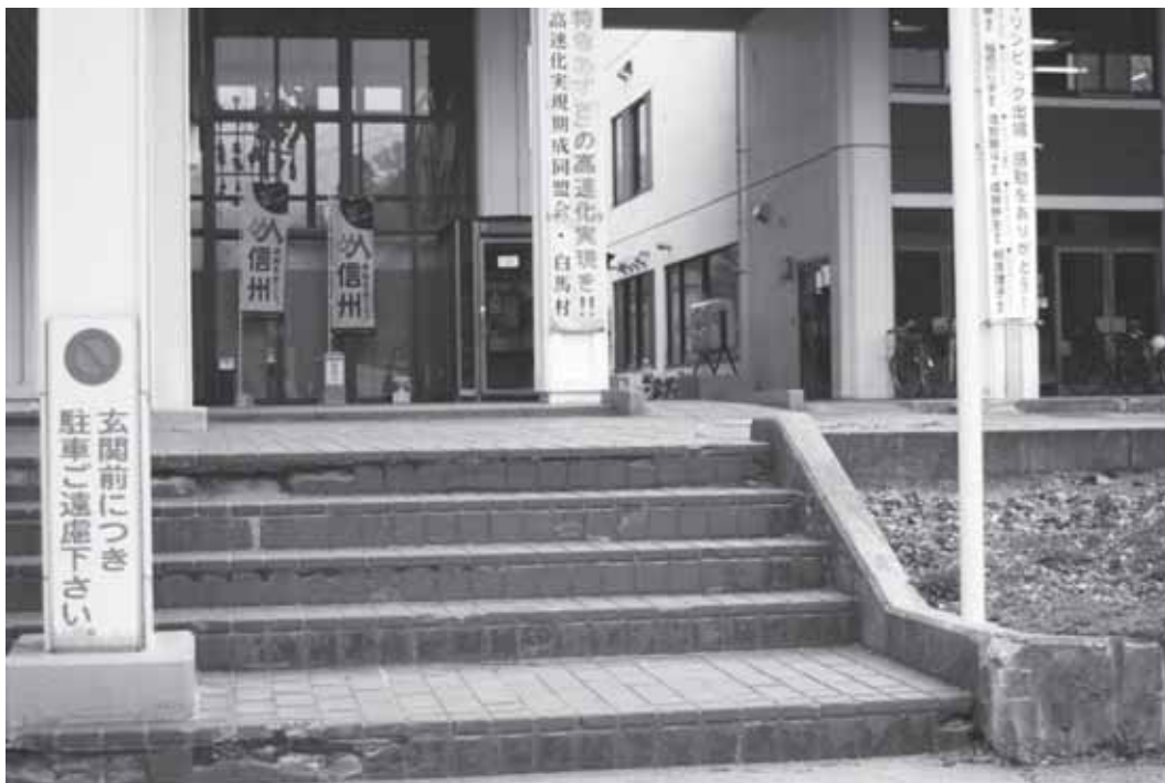
バリアフリー化改修予定の階段 (庁舎玄関)
