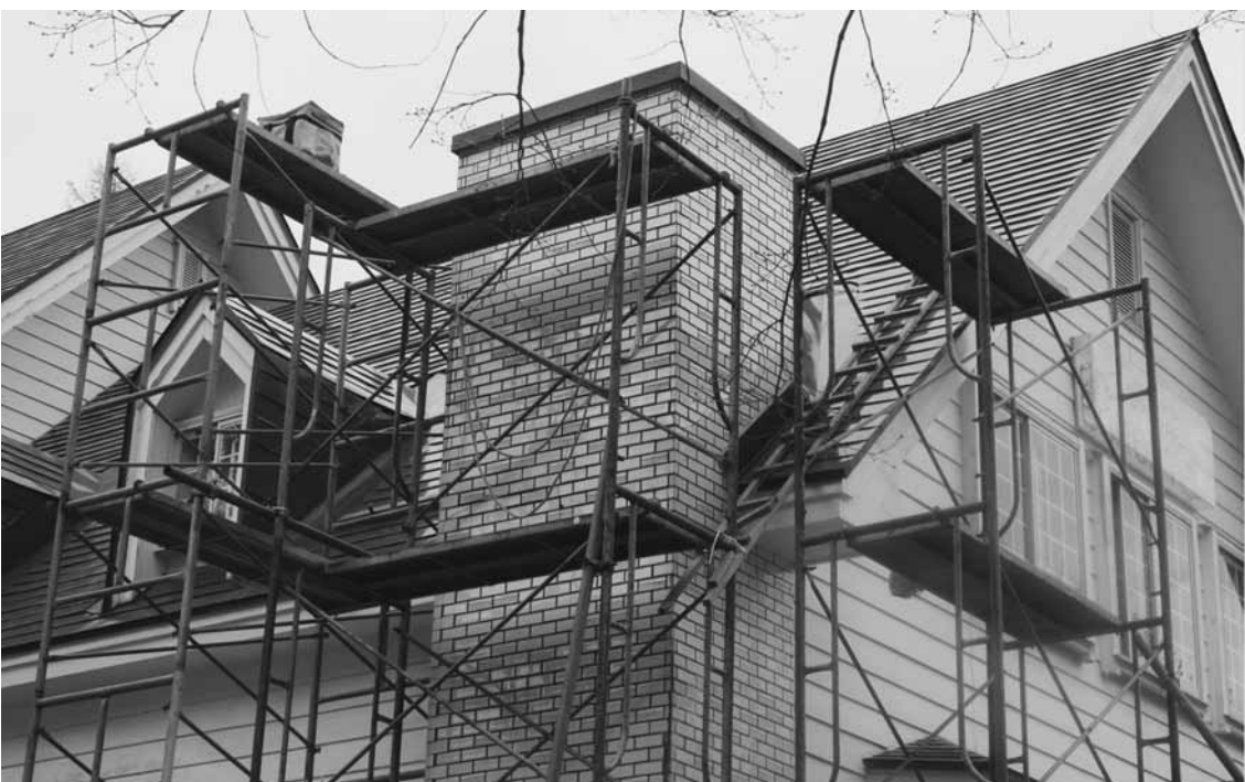
リフォーム中の建物
