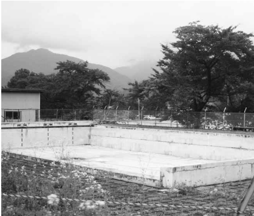
撤去予定の白馬中学校プール
