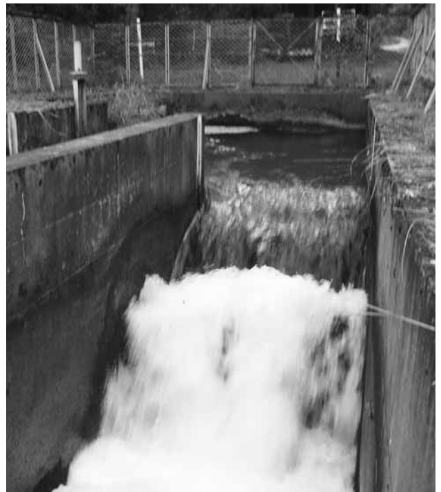
農業水利施設
