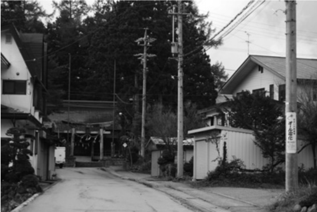
LED化が望まれる街灯
