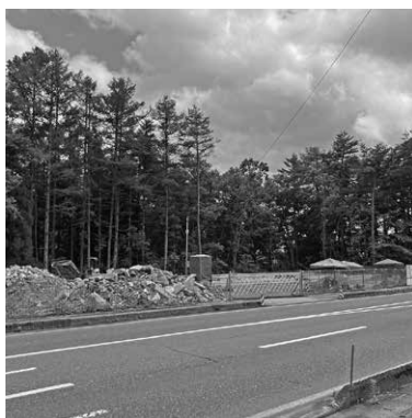
写真左側の一部に掘り出されたコンクリートの残骸の山が見える
