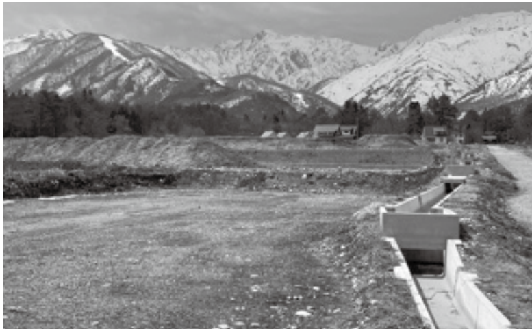
工事が進む北城南部のは場整備。表土の不足が懸念されている。
