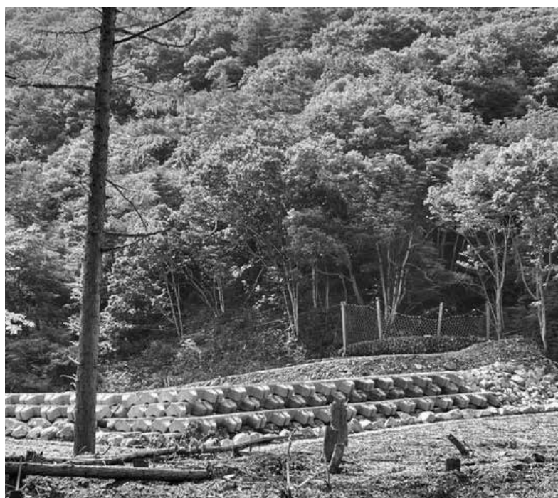
黒豆沢土砂崩落現場では、梅雨の晴れ間に着々と工事が行われている。
