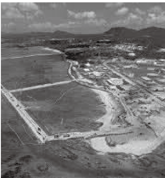
埋め立てが進む辺野古基地建設予定地
