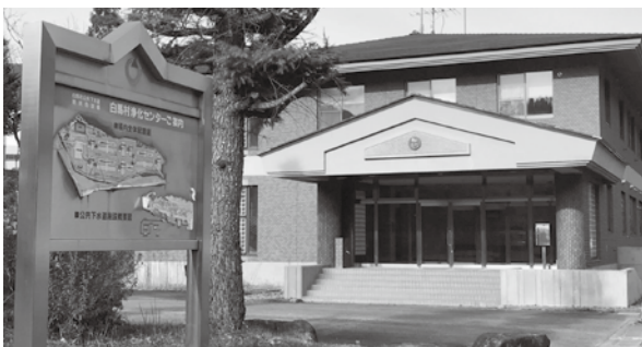
大出地区の白馬村浄化センター
