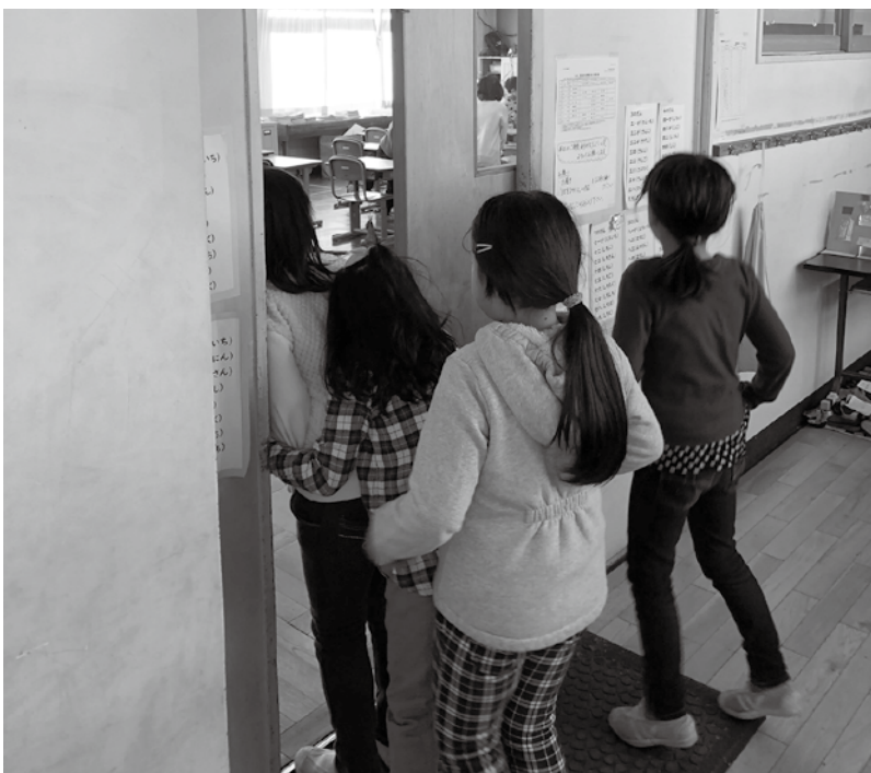
築50年になる北小北校舎は、老朽建物に耐震化工事を施した結果、出入口が1カ所しかない普通教室が3つ、特別教室が3つもある。南小の築年数もほぼ同じ。学校統合検討には早急に着手しなければならない。
