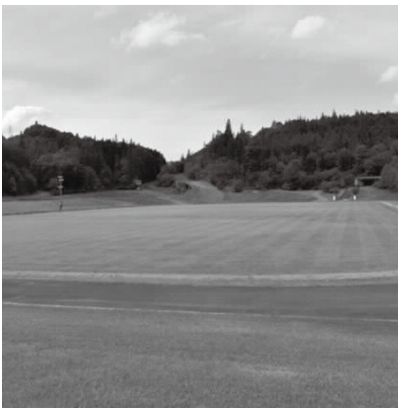
かさむスノーハーブの修繕工事費 積極的な活用を望む
