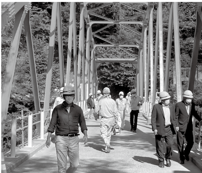
姫川通橋の橋梁修繕工事を視察
