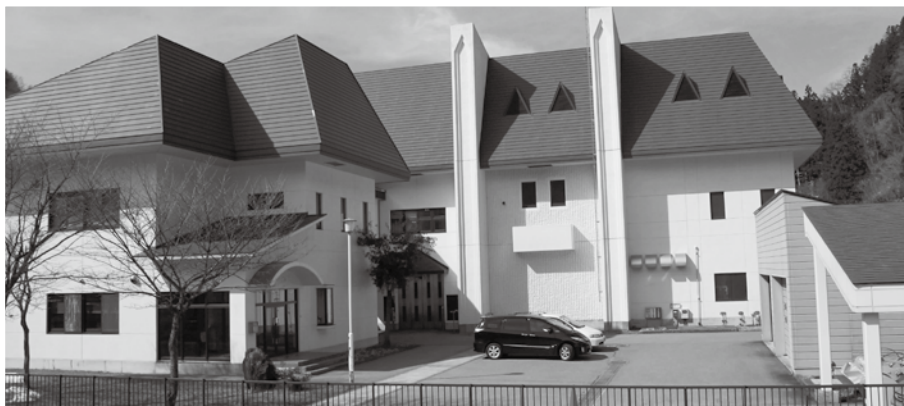
築26年になる白馬山麓事務組合クリーンコスモ姫川(生し尿・浄化槽汚泥処理場)
