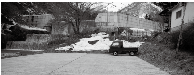
白馬村の「ゼロカーボンシティ」宣言に基づいて建設される小水力発電事業予定地（白馬五竜スキー場入口にある犬川堰堤付近）
