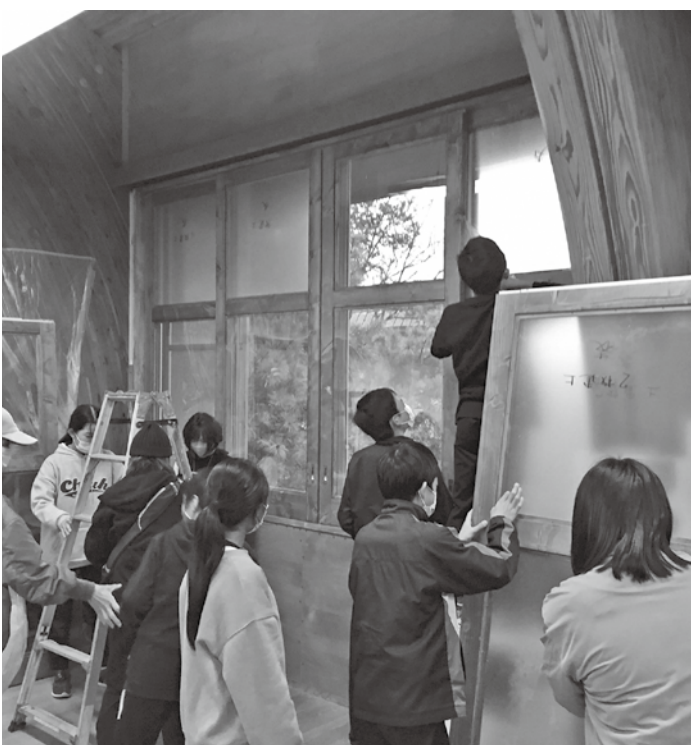
白馬南小学校のPTAと6年生による断熱プロジェクト 壁に断熱材、窓を2重窓に改造した
