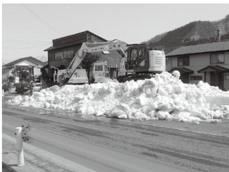
国道の排雪作業
