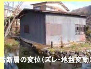
地面の撓曲変形によって、家屋自体が傾く。全壊に至らなかったのは、変位量が小さかったため。
