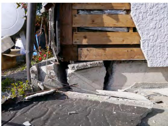
写真3 無筋コンクリート基礎の崩壊
