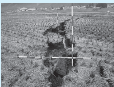
②田圃の亀裂(クラック)
