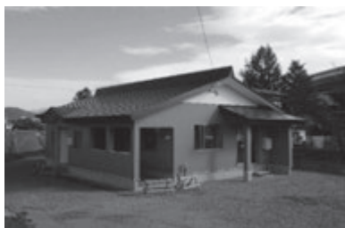
④中学校西住宅
