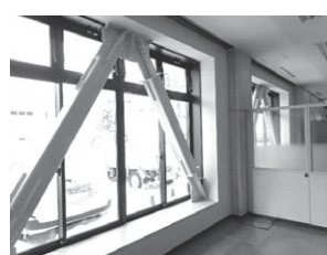
鉄骨ブレースの設置
