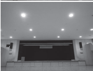
多目的ホールの天井 (上:改修前、下:改修後)
