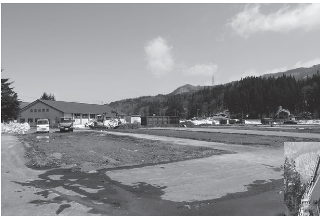
▲▶住宅の解体されたグラウンド（上） 解体作業中の住宅（右）
