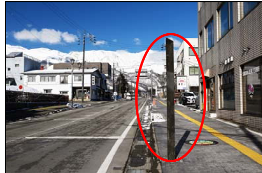
▲新設された街路灯（側面、県道歩道部）
