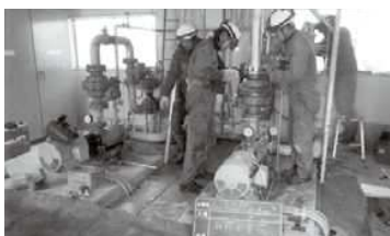
倉下ポンプ室電動弁更新工事
