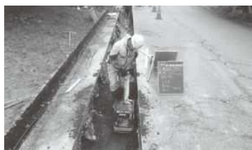
配水管布設替工事(めいてつ)
