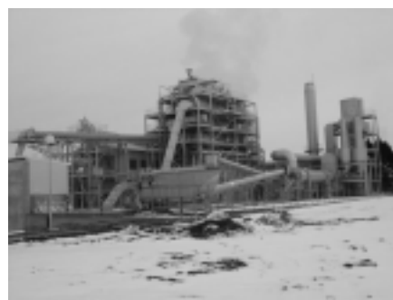
能代バイオマス発電所(秋田県)
