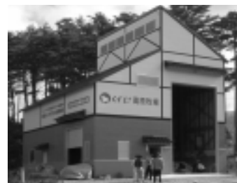
葛巻ガス化発電施設 (岩手県葛巻町)
