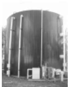
メタン発酵槽
