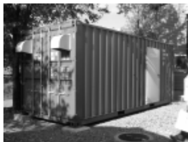
ガスエンジン発電機ユニット
