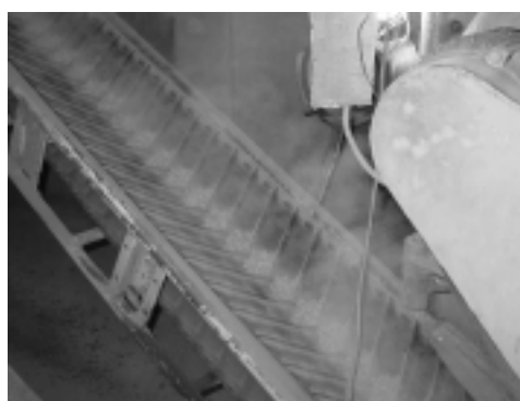
ペレット製造ライン
