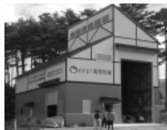
葛巻ガス化発電施設 (岩手県葛巻町)
