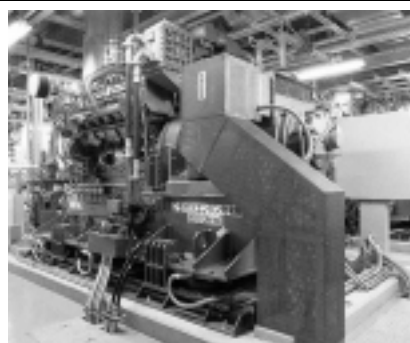
天然ガスコージェネレーション(ガスエンジン) (都立豊島病院(東京都))
