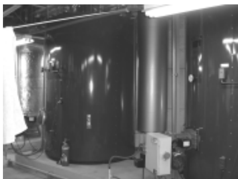
灯油・重油ボイラー
