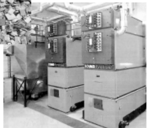
木質チップボイラー
