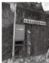
消火栓の取替
