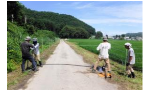
電気柵設置の様子
