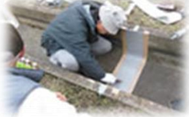
水路の目地補修の様子
