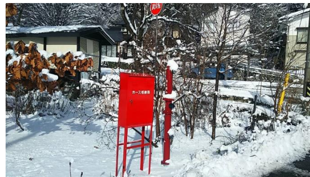
消火栓の取替
