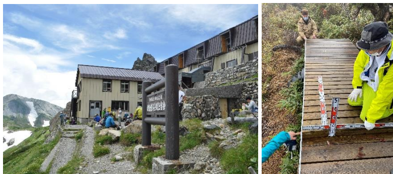
白馬岳頂上宿舎修繕工事
