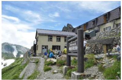
白馬岳頂上宿舎修繕工事
