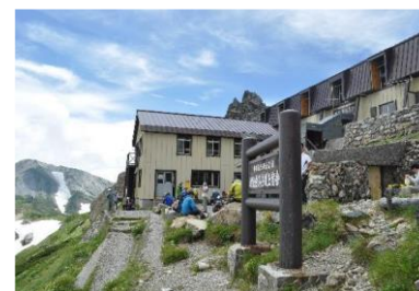
白馬岳頂上宿舎修繕工事
