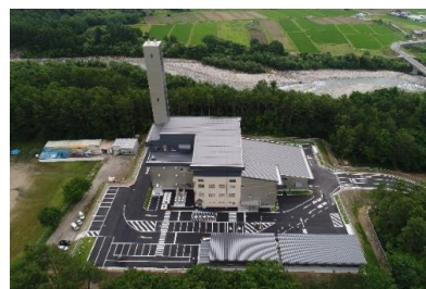
塵芥処理施設（北アルプスエコパーク）
