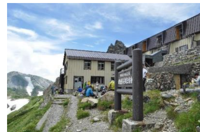
白马岳頂上宿舎修繕工事
