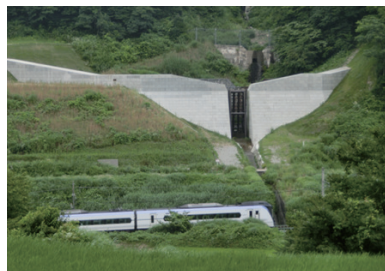
砂防堰堤(小谷村)
