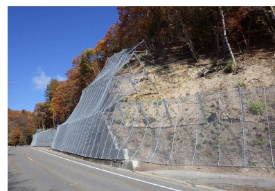
落石対策(大町市)
