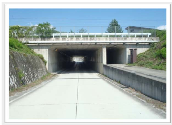
ウイング21大型ボックスカルバート
