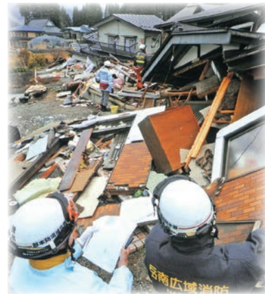
長野県神城断層地震災害による被害の状況
