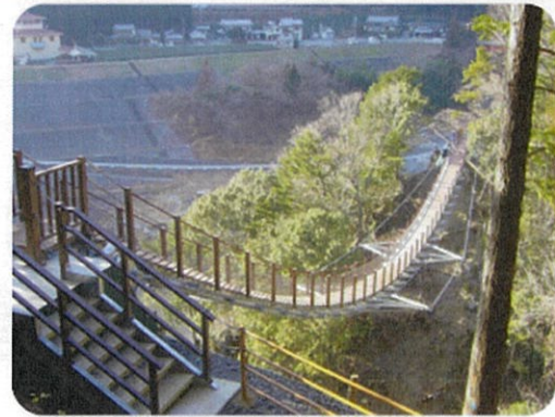
吊床版階段吊橋
