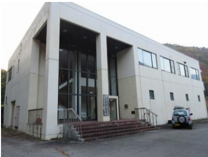
図-6.1.2 現在の二股浄水場の外観
