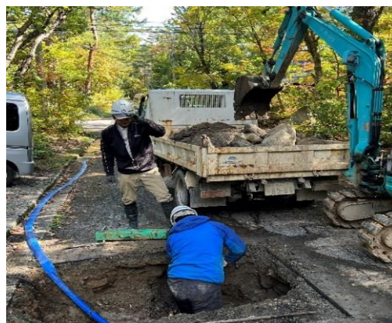
【配水管の漏水修理工事】
