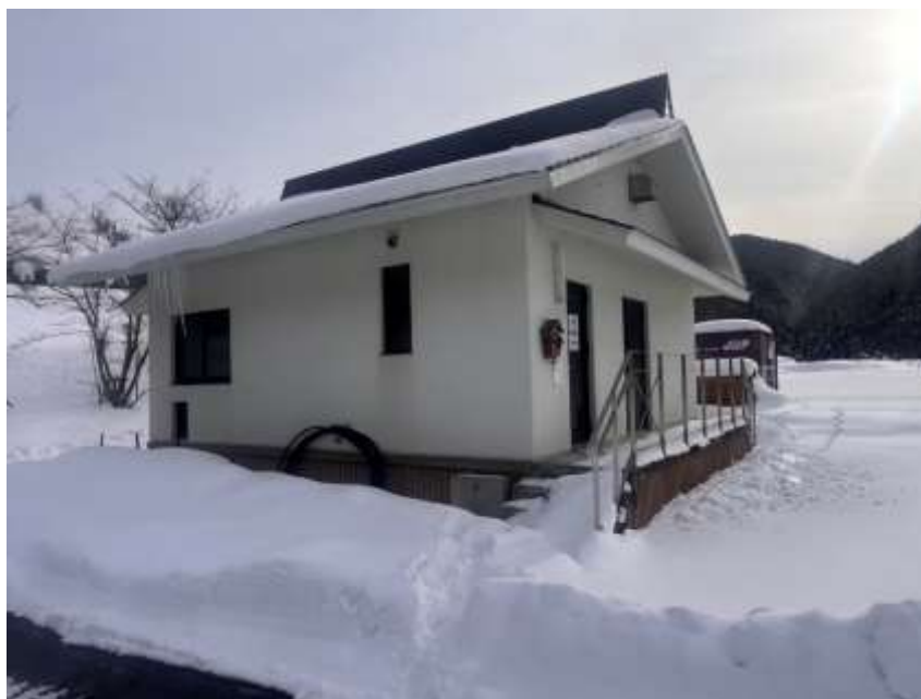
図-2.3.1 野平処理場の外観
