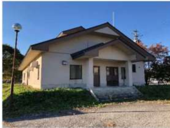
図-2.2.3 東部送水ポンプ場の外観
