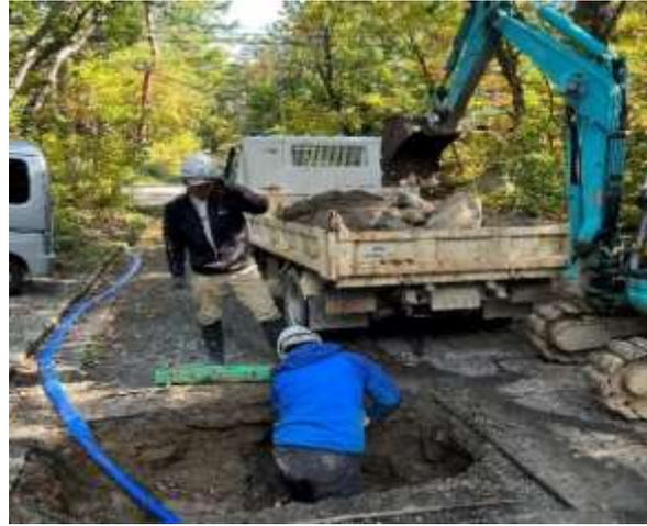
【配水管の漏水修理工事】
