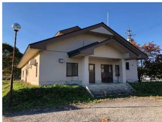
図-2.2.3 東部送水ポンプ場の外観
