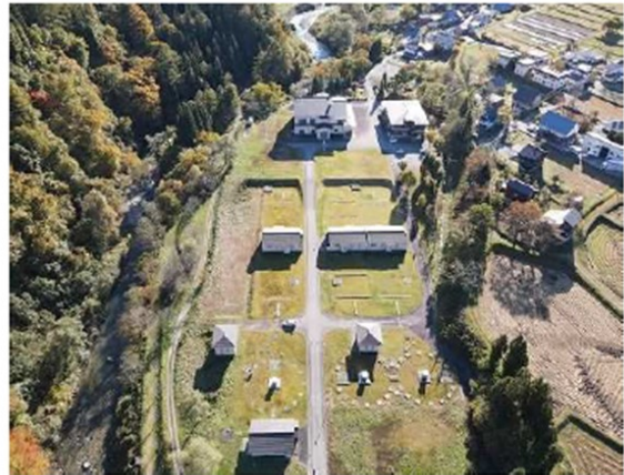
図-2.2.1 白馬村浄化センターの外観・全景
