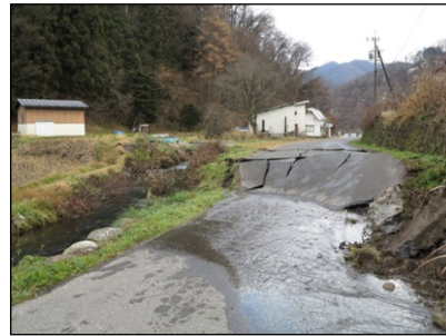
図-6.3.1 H26 神城断層地震による村道の隆起
