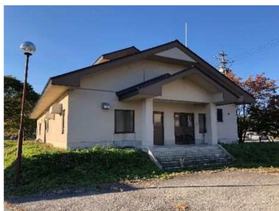
図-2.2.3 東部送水ポンプ場の外観
