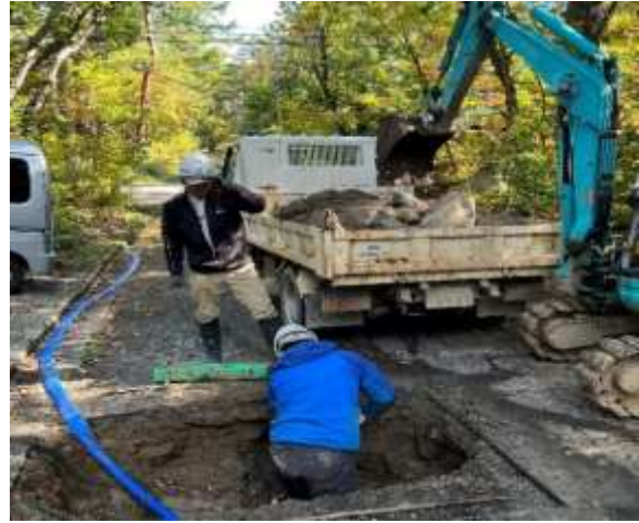
【配水管の漏水修理工事】
