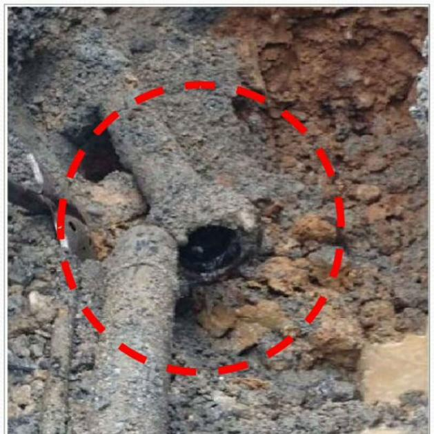
写真4-2 2014年神城断層地震で被災した嶺方地区送水管
