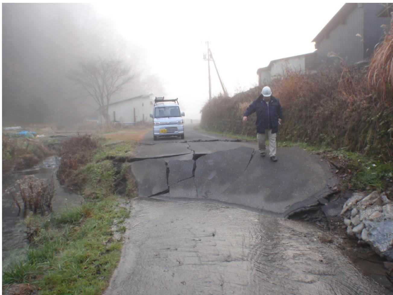
写真6-1 H26 神城断層地震後に陥没した村内の道路
