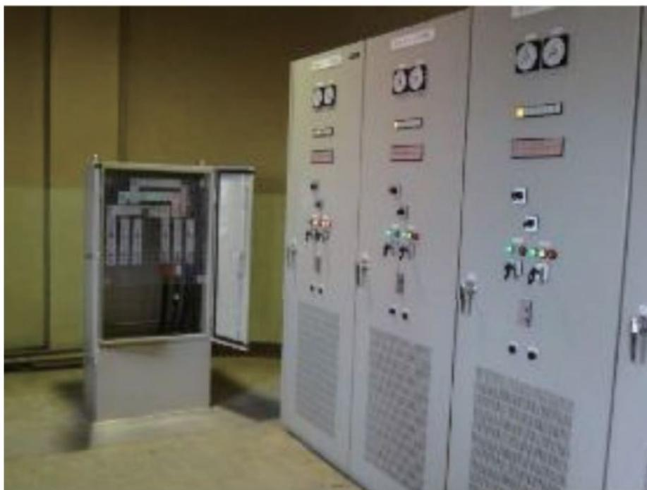
写真6-3 可搬式仮設発電機から給電を受ける接続端子
