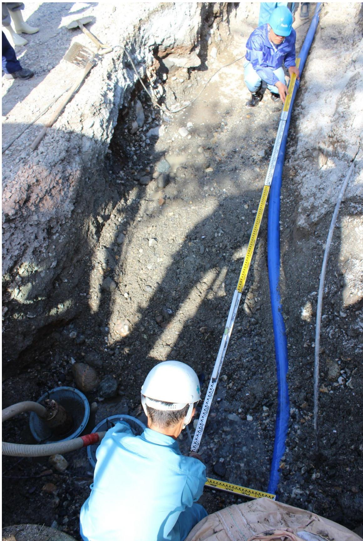
写真6-2 陥没した道路でも破断せずに通水機能を維持している配水用ポリエチレン管
